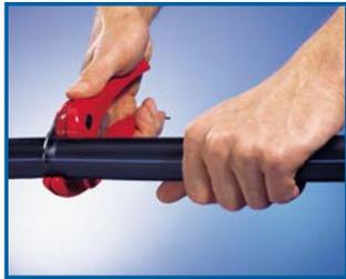
Rohr mit Schere für Kunststoffrohr durchschneiden.
